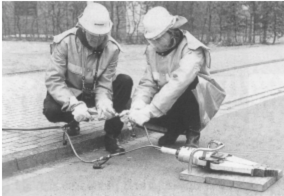
Verbinden der Hydraulikleitungen
